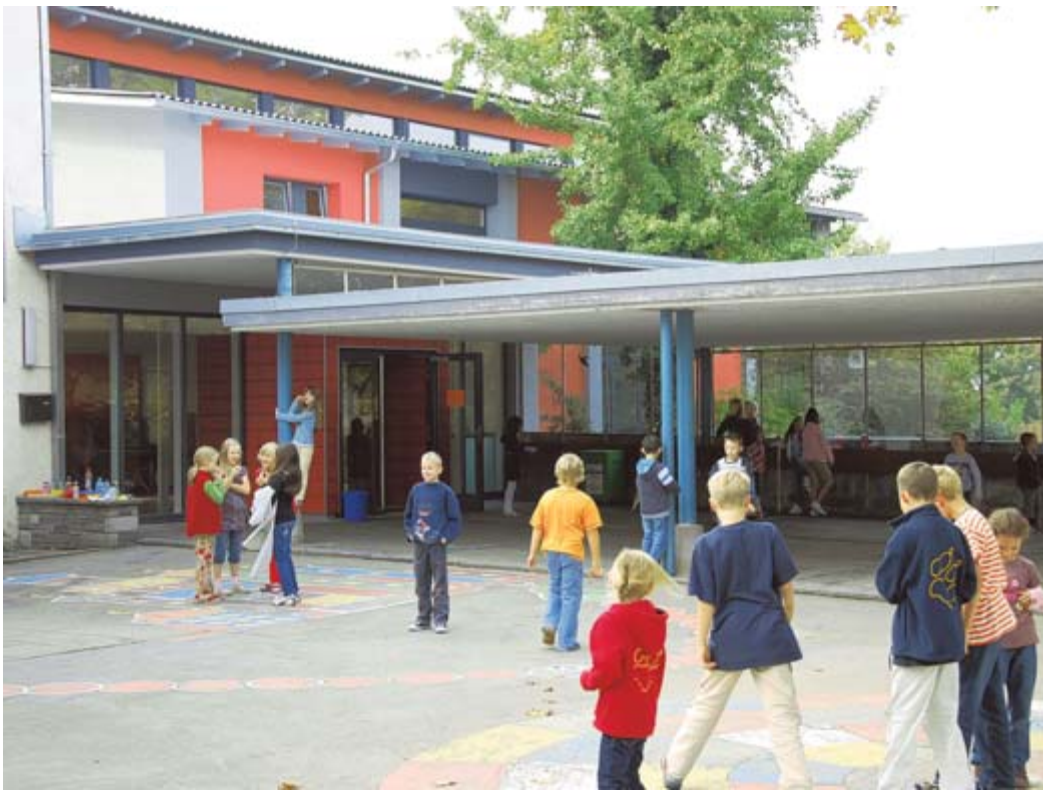
Eine grundlegende Erneuerung erfuhren der im Jahre 1962 errichtete Anbau (hinten) der Grundschule Dogern. Am 4. Oktober kann die Bevölkerung das renovierte Gebäude besichtigen.
